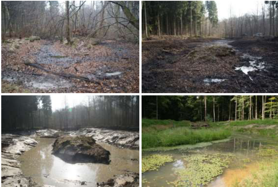
Gewässeroptimierung vor Beginn der Maßnahme (o. l.), nach der Freistellung (o. r.), nach der Erweiterung und Optimierung (u. l.), 4 Monate nach Maßnahmenumsetzung (u. r.)
