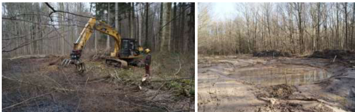
Freistellungsmaßnahmen am Rehsprungmaar (links), Neuanlage einer Gewässermulde auf einer Waldlichtung (rechts)
