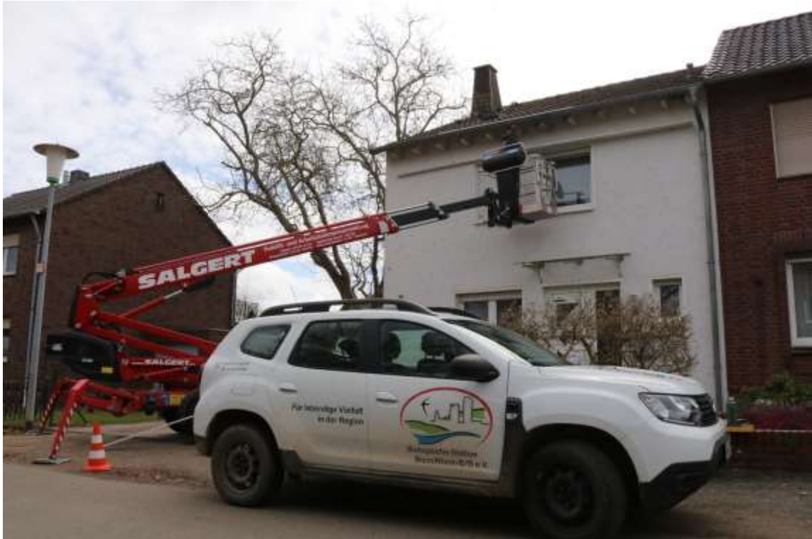
Beim zweiten Teil der Schwalben-Aktion wurden Arbeiten durchgeführt, die nur mit Hebebühne bewerkstelligt werden konnten. Hier die Montage von 6m Kotbrettern an einer Mehlschwalbenkolonie in Ahrem.
