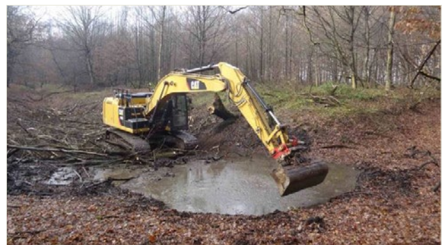
Optimierung des letzten verbliebenen Reproduktionsgewässers der Geburtshelferkröte am Rand des Annaberger Feldes
