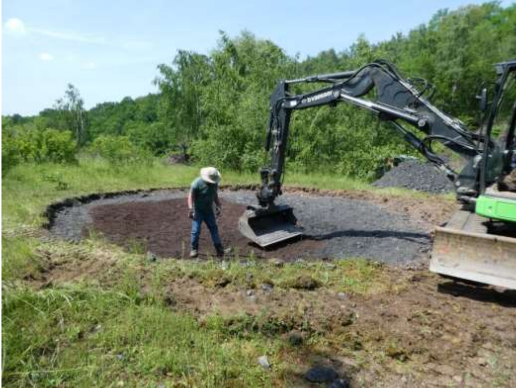
Ausheben Gewässermulde, mit Sand o.ä. auskleiden
