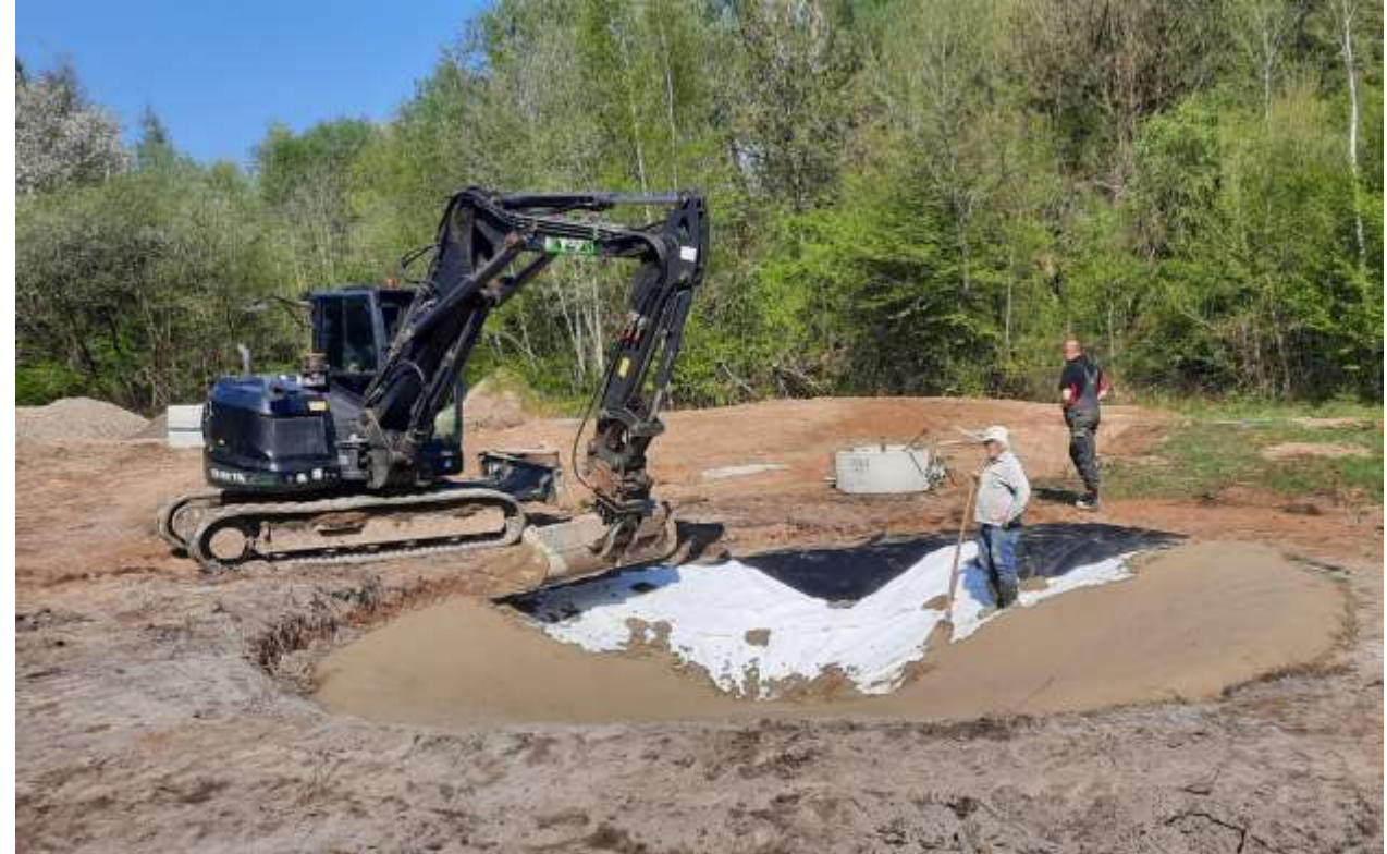
Vlies, EPDM-Folie, Vlies, Betonschutzschicht mit Kunststofffasern
