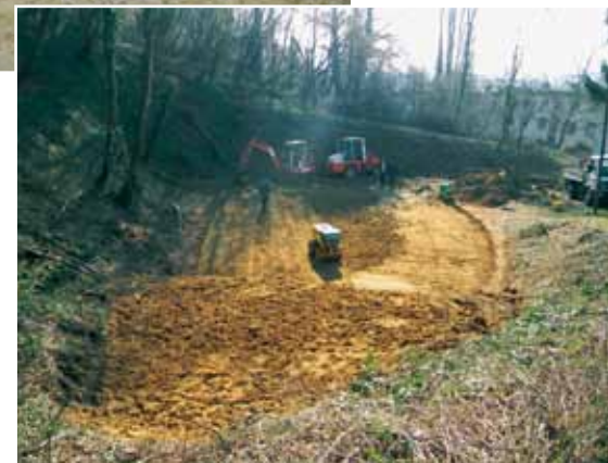
Abb. 8: 04.03.2011: Nahezu fertige Abdichtung.
