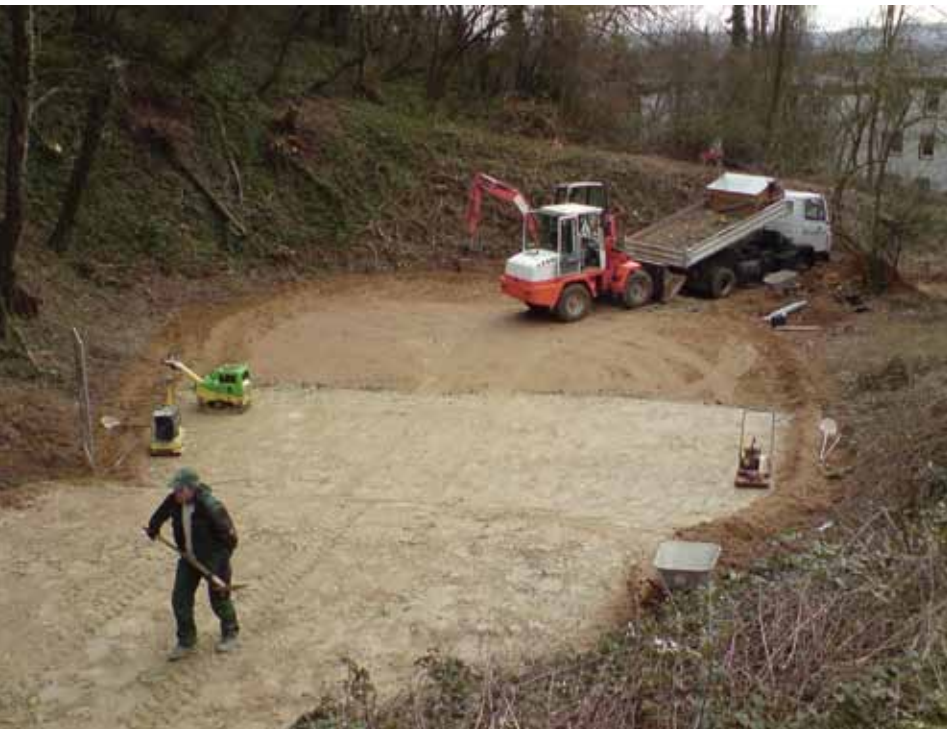
Abb. 9: 10.03.2011: Einbringen der 10 cm dicken Abdeckschicht.
