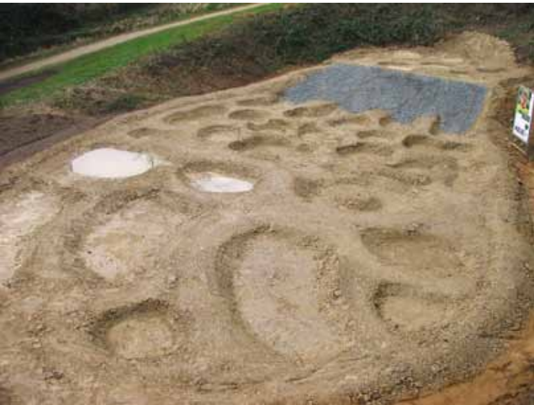
Abb. 11: 15.03.2011: Befestigte Böschung und Testbefüllung einzelner Gewässer.
