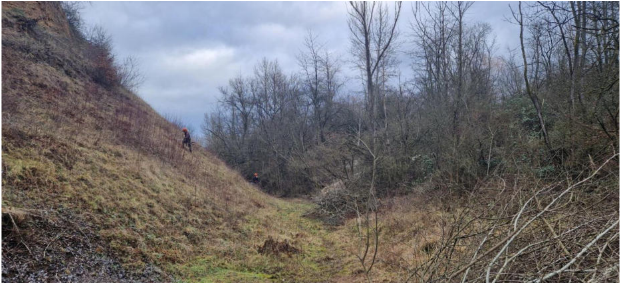
Freischneiden des Zauneidechsen-Hangs in Kiesgrube an der Alfterer Straße im Januar 2025. Deutlich zu sehen sind die Bäume, die vor allem im Frühjahr und Frühsommer Schatten auf den Hang werfen.
