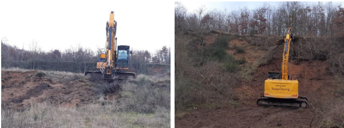
Bagger bei der Entnahme flächiger Bestände von Ginster, Brombeeren und Zitterpappel (links) und der Freistellung einer großen südwestexponierten Böschung zur gezielten Schaffung von Lebensräumen für wärmeliebende Insekten (rechts)
