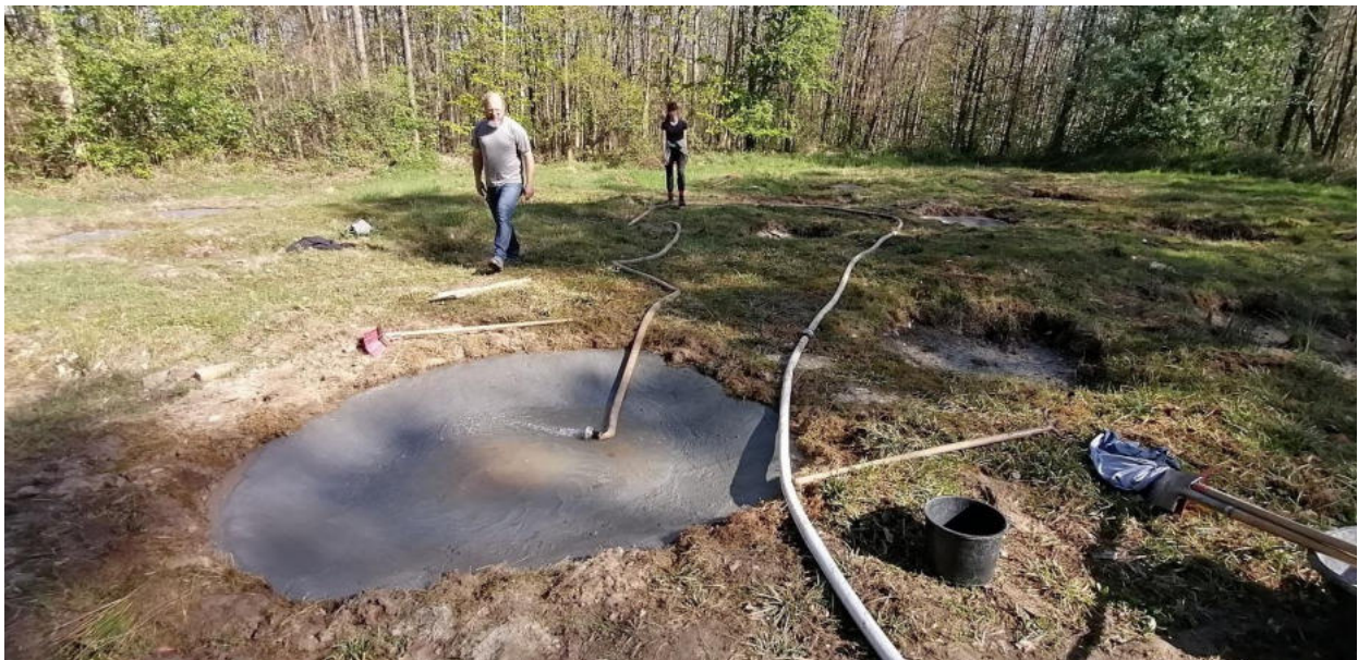
Reinigung und erste Befüllung der Betontümpel im Ennert
