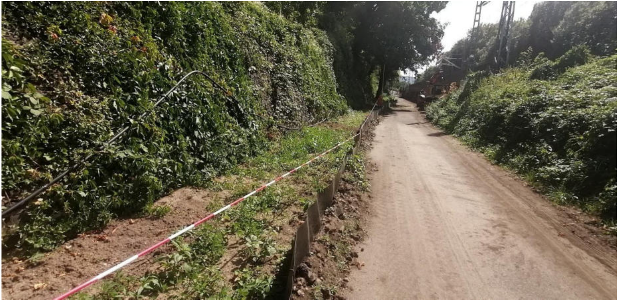
Mauern in Bonn Oberkassel im Bereich von Baumaßnahmen der DB. Der schwarze Folienzaun soll verhindern, dass Tiere auf Straße oder in Baufeld geraten (Sommer 2025).
