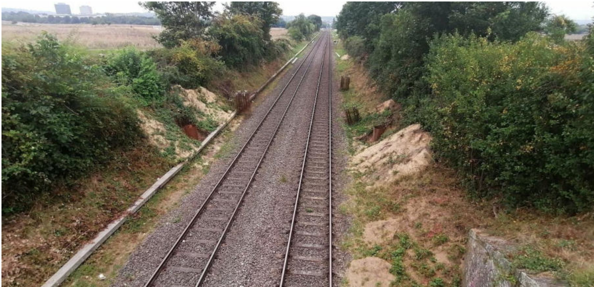
Mastenbau an der S 23 im Meßdorfer Feld, im Habitat der Zauneidechse
