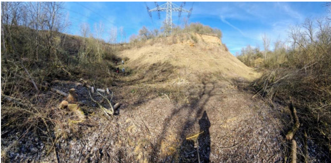
Beginn der Freischneide- und Fällarbeiten, um die Besonnung des Eidechsenlebensraums zu verbessern
